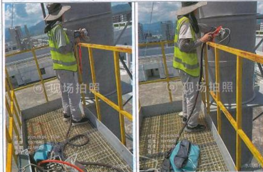
FQ-9-2439-02B 酸性废气排放口处理后
