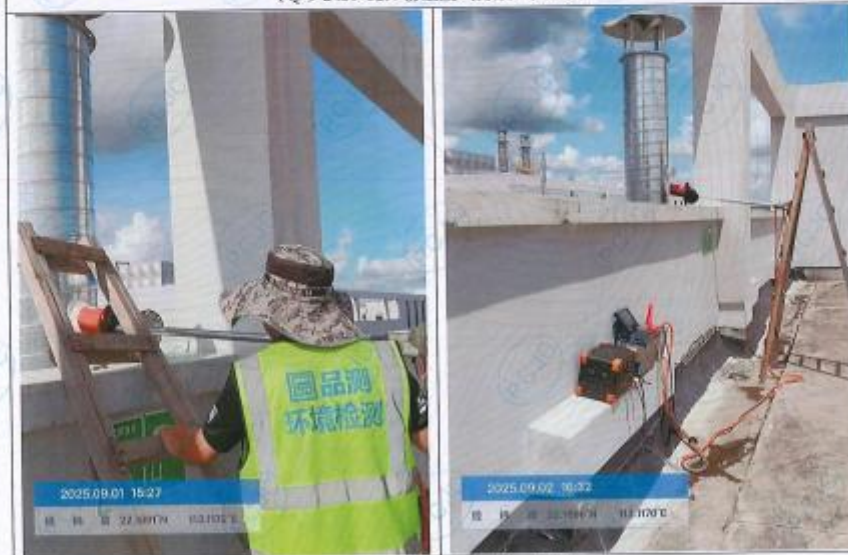
FQ-9-2439-02J 粉尘废气排放口处理后
