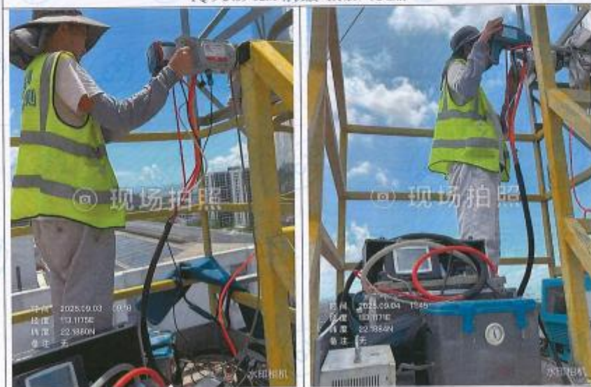
FQ-9-2439-02M 有机废气排放口处理后
